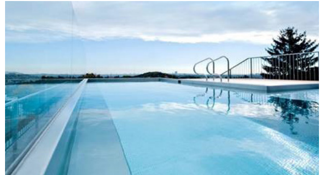
Becken mit Überlaufrinne
