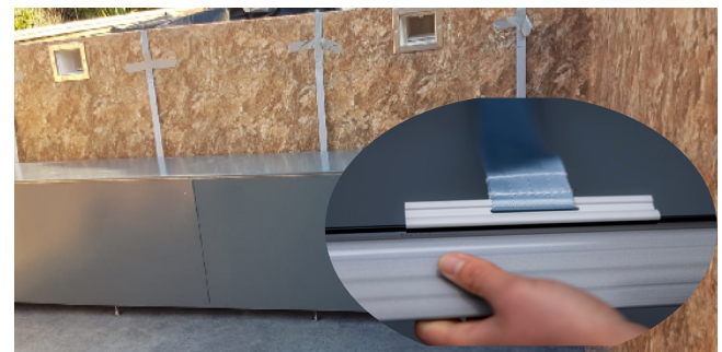
Bild: Befestigung erste Lamelle
