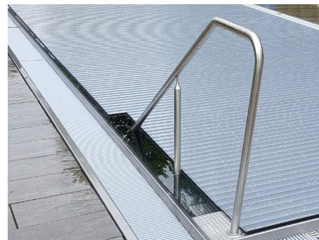
Bild: Becken mit Überlaufrinne
